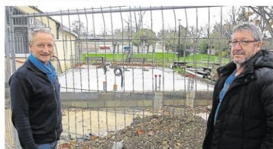
Gilles Hilaire à gauche, président du conseil d'administration du centre social Edith-Bonnem et le directeur, Dominique Croissant, appréciant l'avancée du chantier pour la construction de l'extension du bâtiment.
